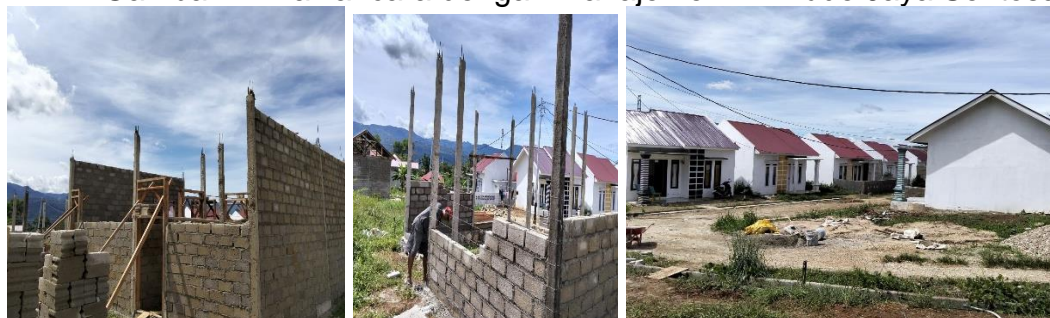
Gambar 2. Proses pembangunan rumah subsidi tipe 36/99 di Perumahan Transad Indah Residence Tahap 2
